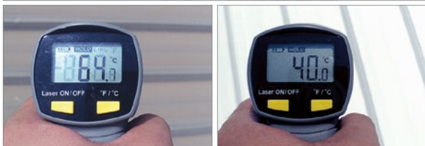
Průmyslová hala v Malajsii. Střecha haly zvenčí (před-po realizaci): Střešní nátěr přinesl snížení teploty o 24,7°C.
