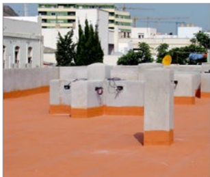
Španělsko: Bytový dům, Vera
